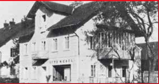
Alapítóház Haag am Hausruckban (1945)
